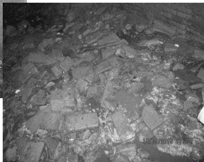
Particolare materiale sul fondo della canaletta Fiaccacollo
