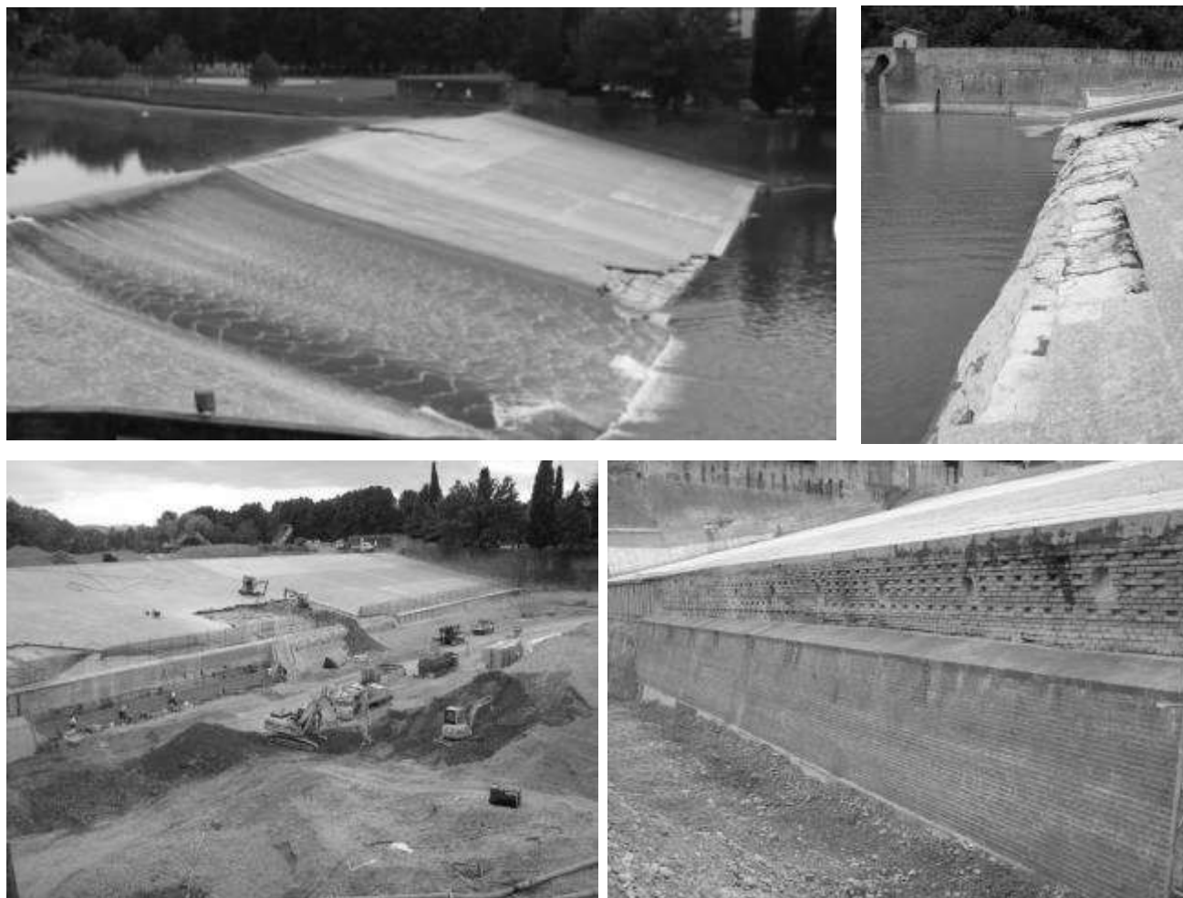
Figura - La chiusa di Casalecchio di Reno prima, durante e dopo l'intervento di riqualificazione
