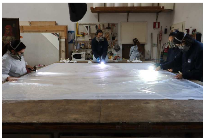
20 a-b-c – applicazione della tela precollata riattivata con butilacetato
